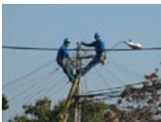
Cuadrilla de Chilectra trabajando para restablecer el servicio eléctrico de la capital.
