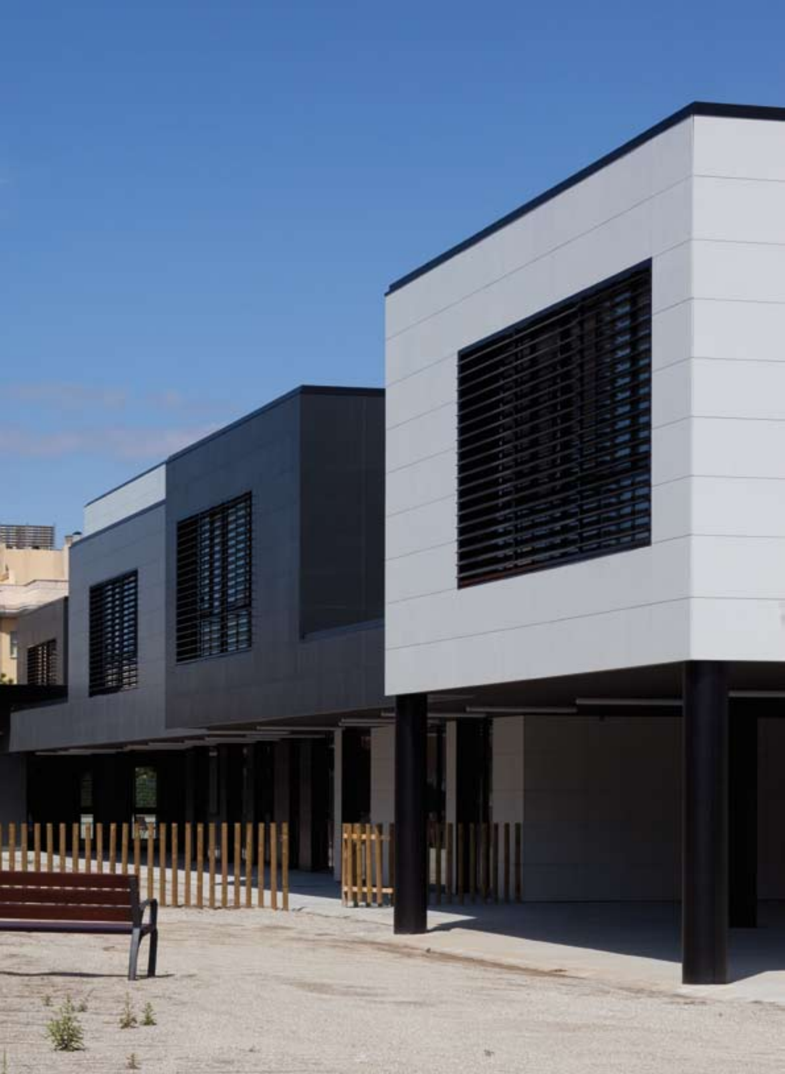
Construcción del CEIP Mar i Cel de Cubelles (Barcelona) Arquitecto: Espinet-Ubach
