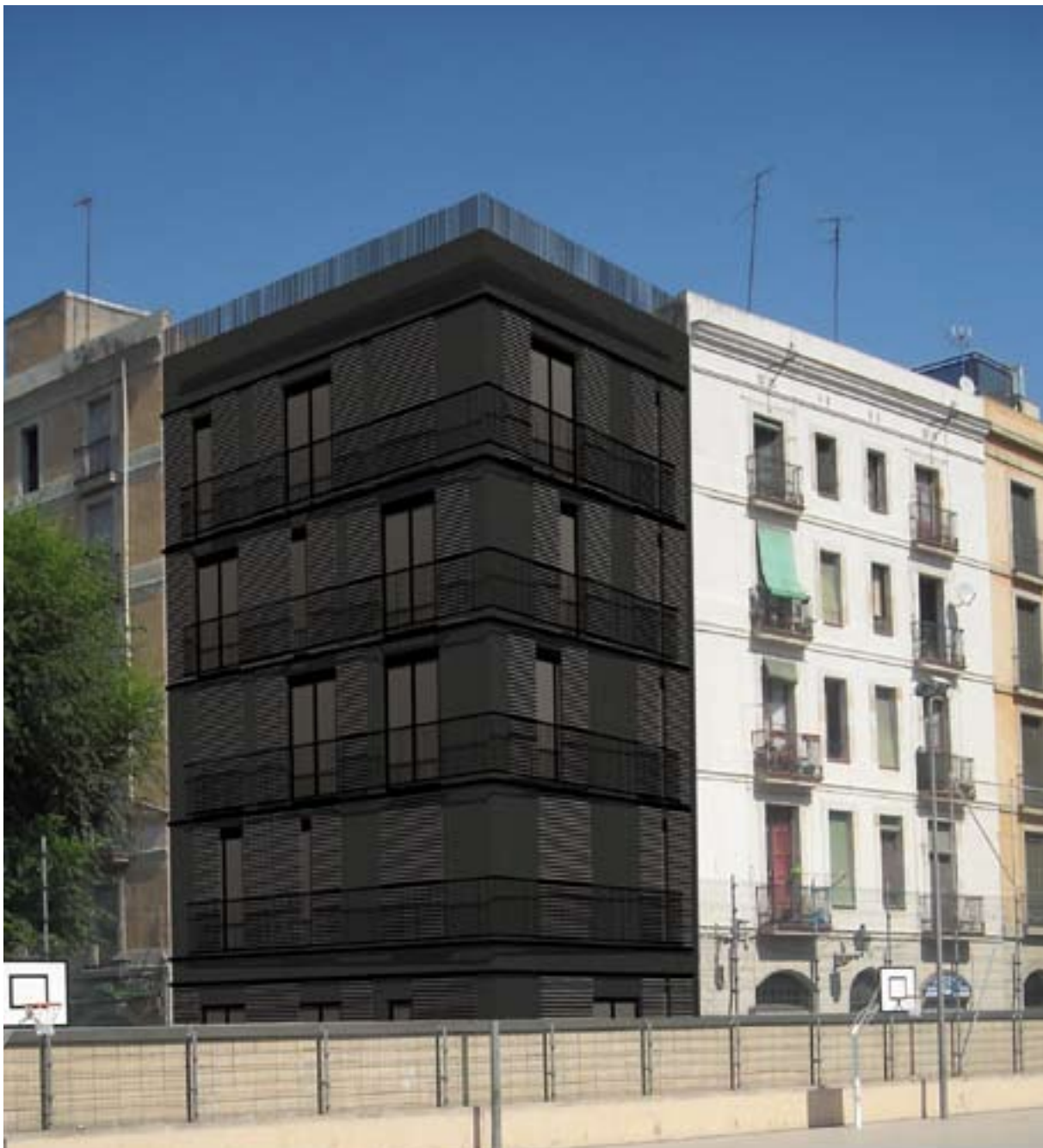
Proyecto en la calle Arc del Teatre de Barcelona Arquitecto: Daniel Gallego
