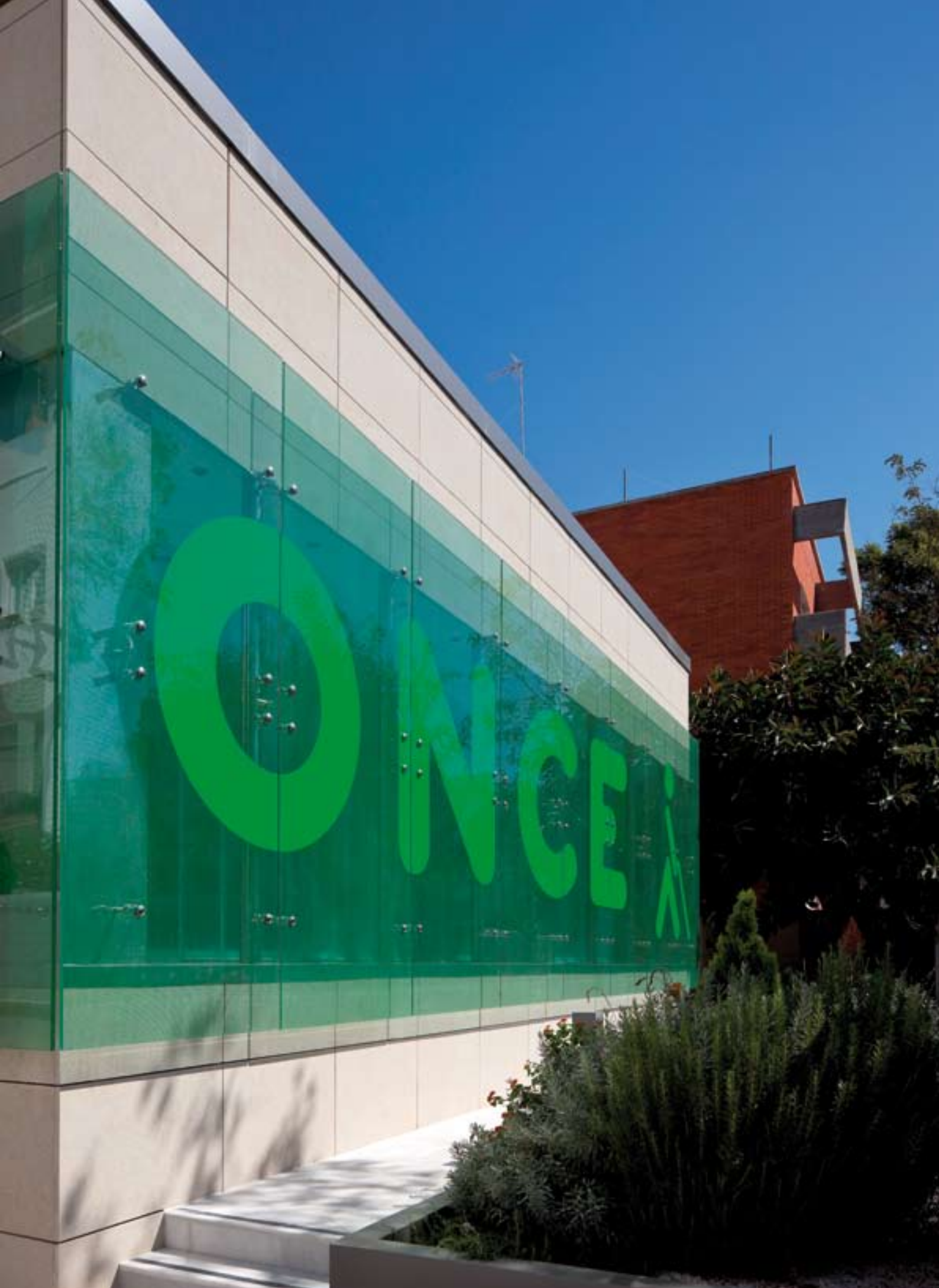
Reforma de la Dirección Administrativa de la ONCE en Cádiz Arquitecto: Luis Dávila
