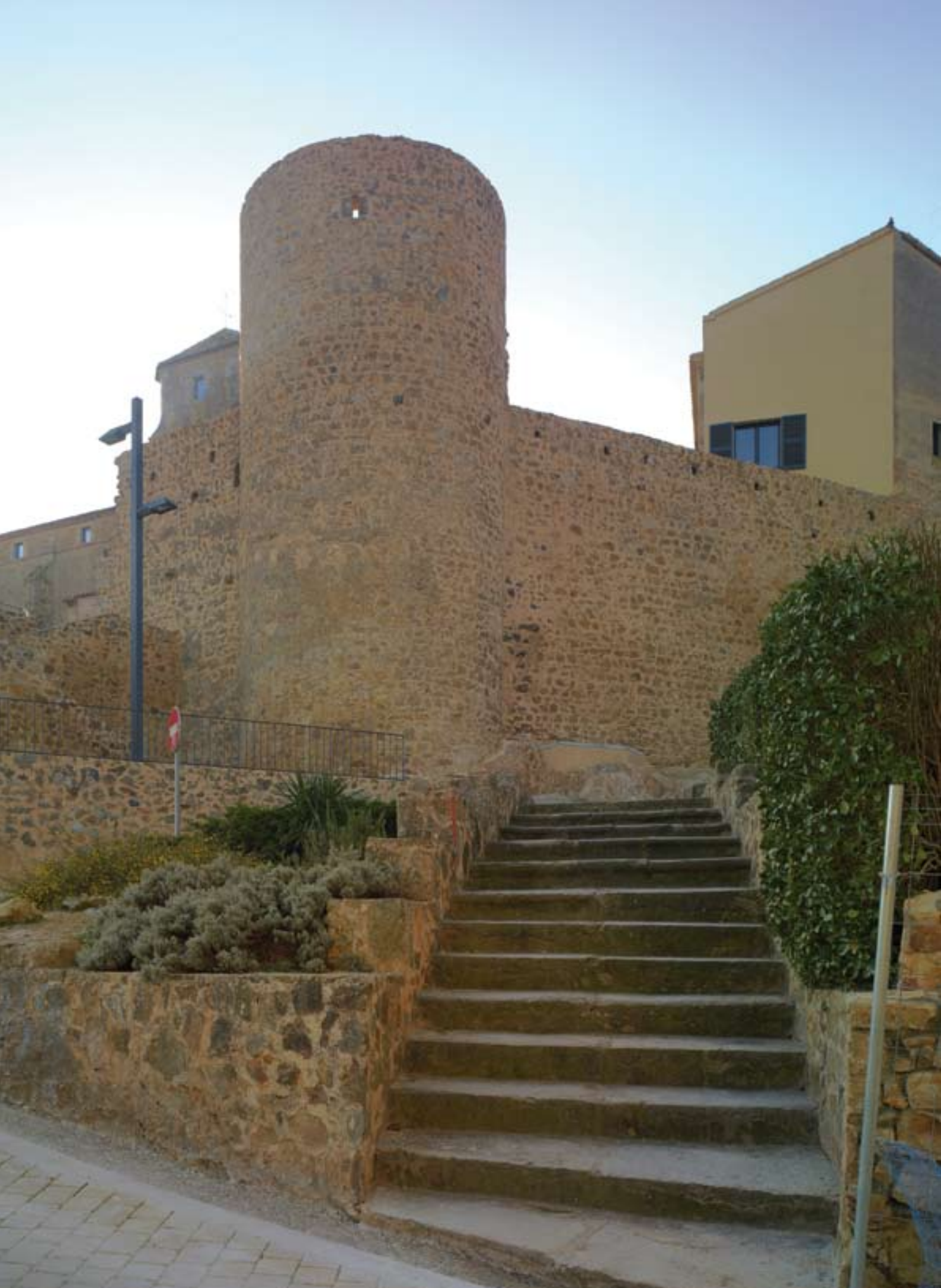
Recuperación de la muralla de Llagostera (Barcelona) Arquitecto: Bosch Frigola Arquitectes
