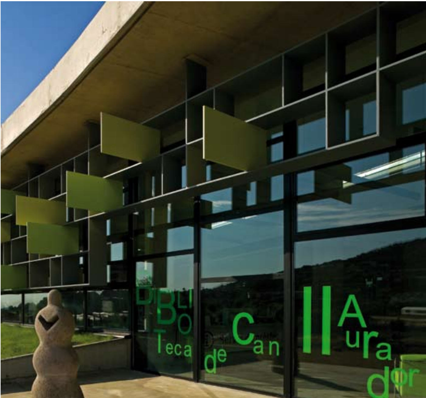
Construcción de la Biblioteca de Can Llaurador en Teià (Barcelona) Arquitecto: Sergi Godia / Berta Barris
