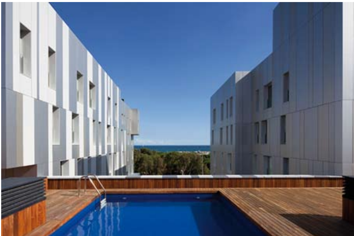
Construcción de edificio de viviendas, locales y aparcamiento en la calle Bilbao de Barcelona Arquitecto: LLuis Cantallops Valeri
