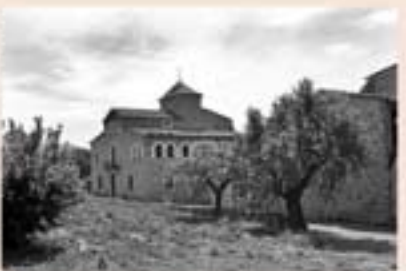
Vista de la masía de Falset (Priorat) que se está rehabilitando.
