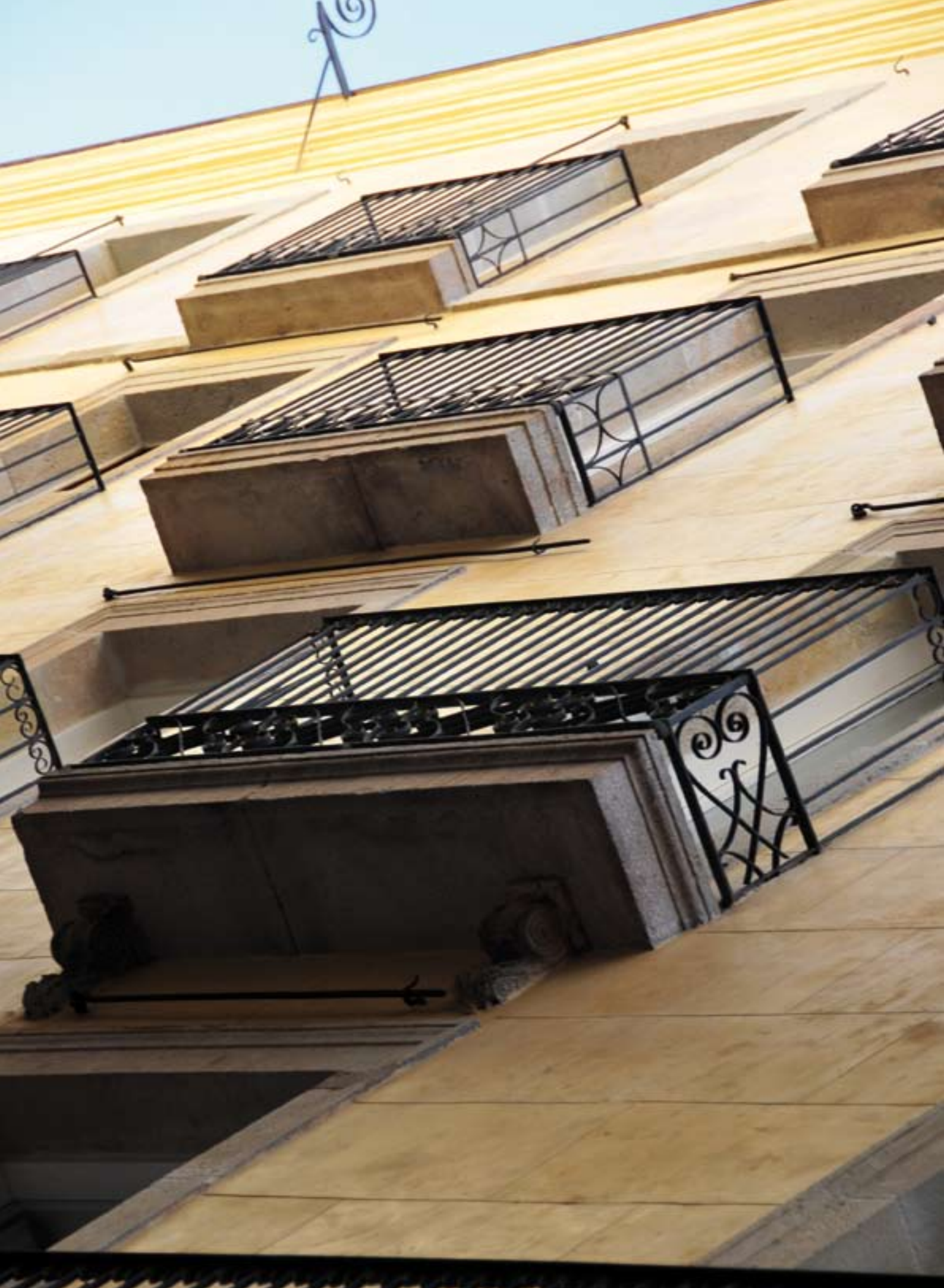
Edificio destinado a régimen de alquiler en la calle Ataül de Barcelona Arquitecto: Ernest Compta
