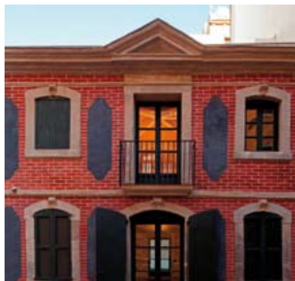
Rehabilitación de la 'Casa del Porró' (Barcelona) Arquitecto: Francisco Sandalinas Linares
