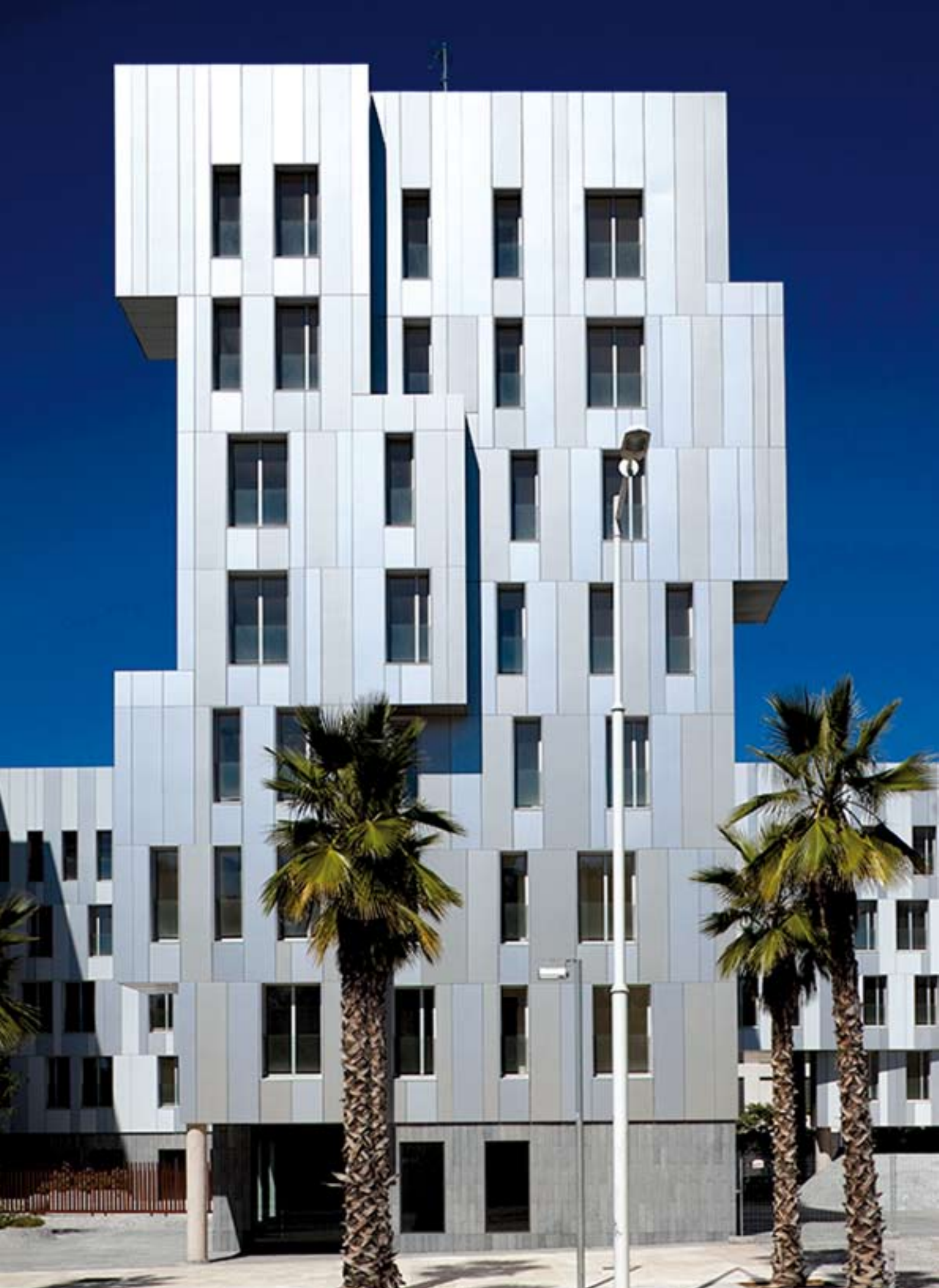
Construcción de edificio de viviendas, locales y aparcamiento en la calle Bilbao de Barcelona Arquitecto: Lluís Cantalops Valeri
