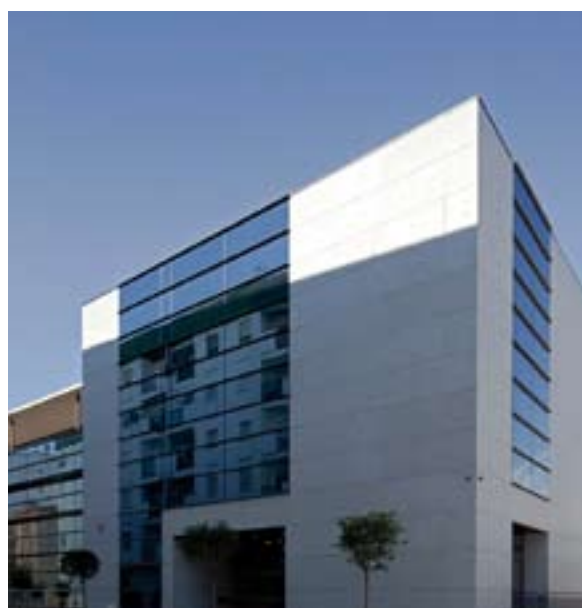
Construcción de la TGSS en Andújar (Jaén) Arquitecto: José Luis Rodríguez
