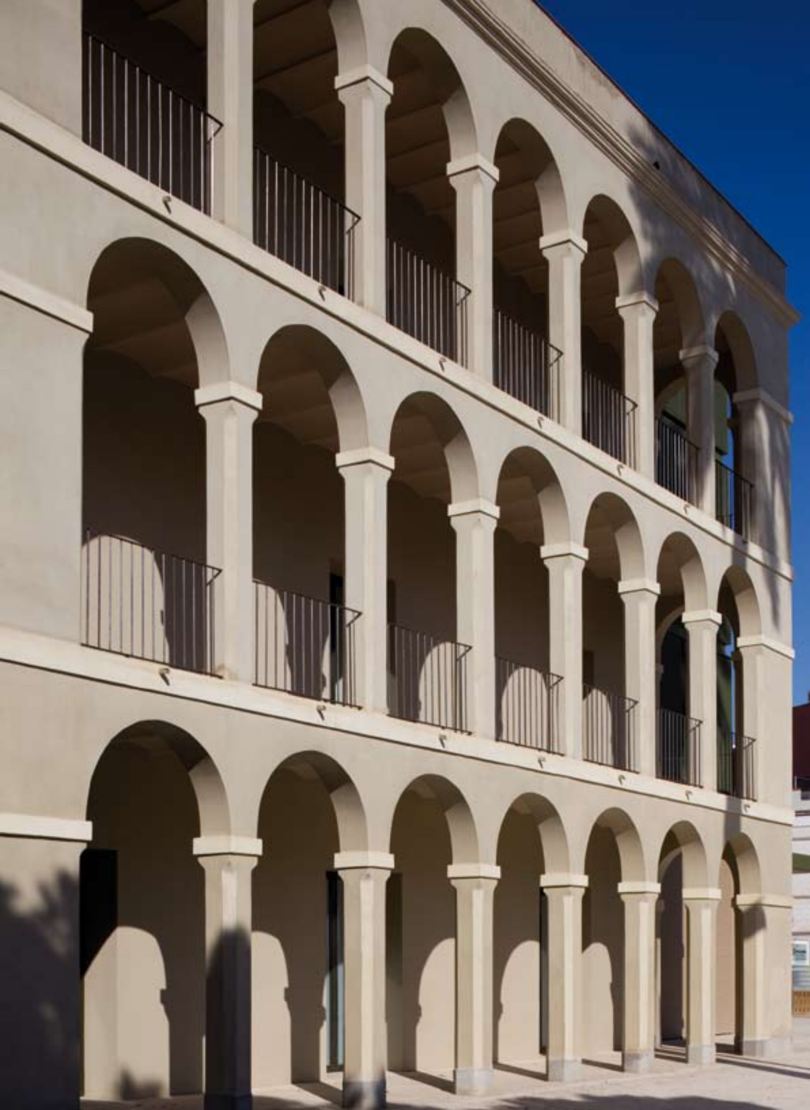
Rehabilitación del edificio 'Torre Barrina' en l'Hospitalet de Llobregat (Barcelona) Arquitecto: Narcís Roig
