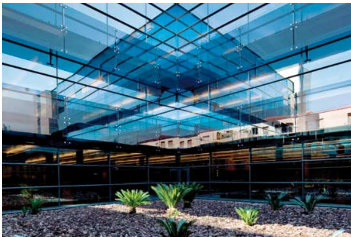
Construcción de la TGSS de Andújar (Jaén) Arquitecto: José Luis Rodríguez Aramberrí
